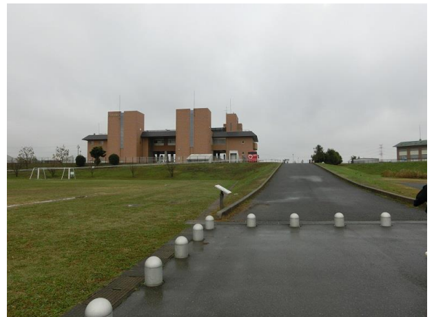
左側の芝生の下は地下貯水槽
