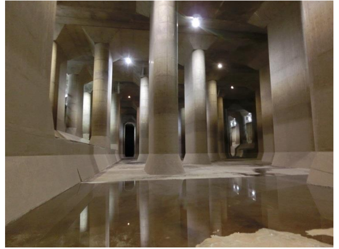
長さ177m 幅78m 高さ18mの地下貯水槽
