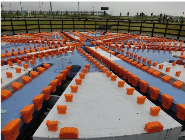
10.6mの工事で使用したシールドマシンの歯(ビット)
